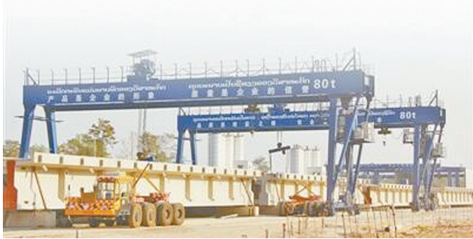
中老鐵路萬象制梁場遠景
