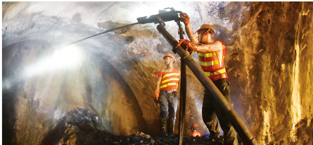
▲大柱山隧道内，铁路建设者在40摄氏度的环境中作业 新华社图
