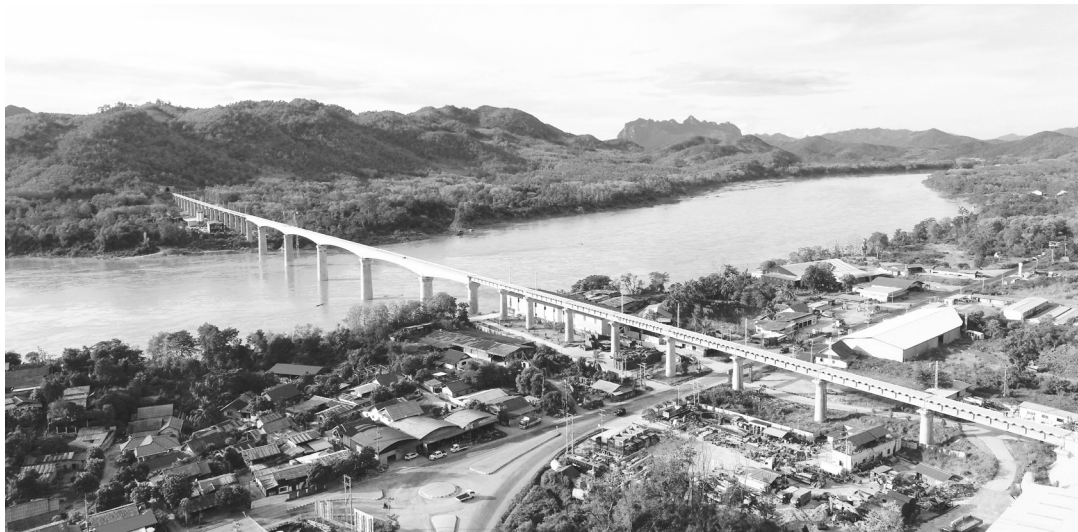
▲中老铁路琅勃拉邦湄公河特大桥 新华社图
